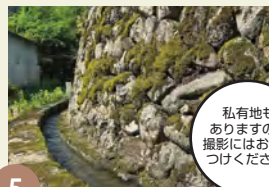
5 水間道と石積みと水路
